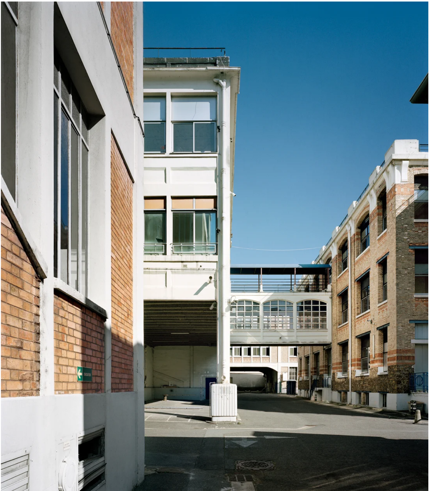
Poush à Aubervilliers (Seine-Saint-Denis), ancienne usine reconvertie en pépinière d'ateliers d'artistes ⓘ
